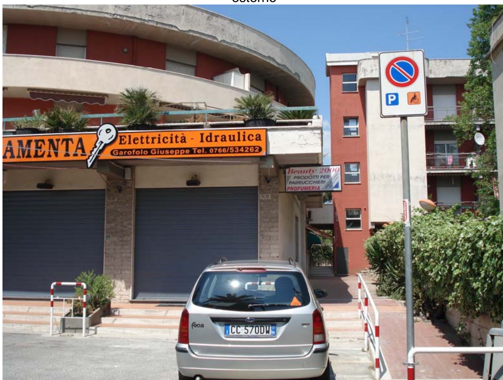
accesso da Via Aurelia
