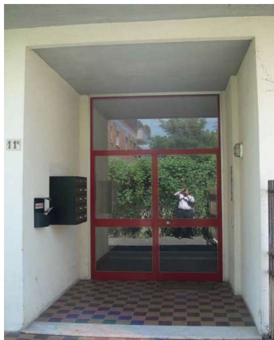
Portoncino d'ingresso condominiale
