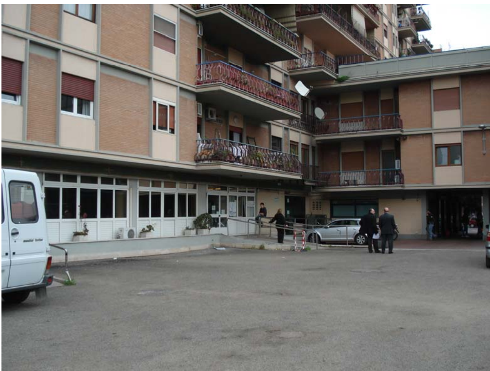
esterno verso corte interna
