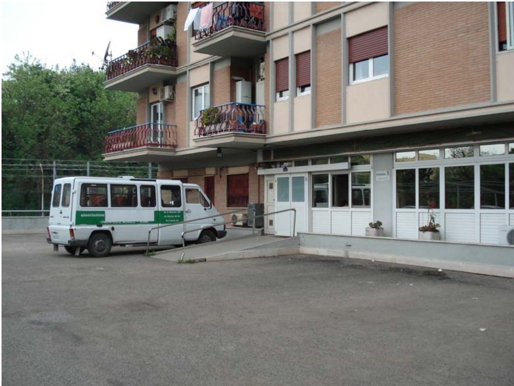
esterno verso corte interna
