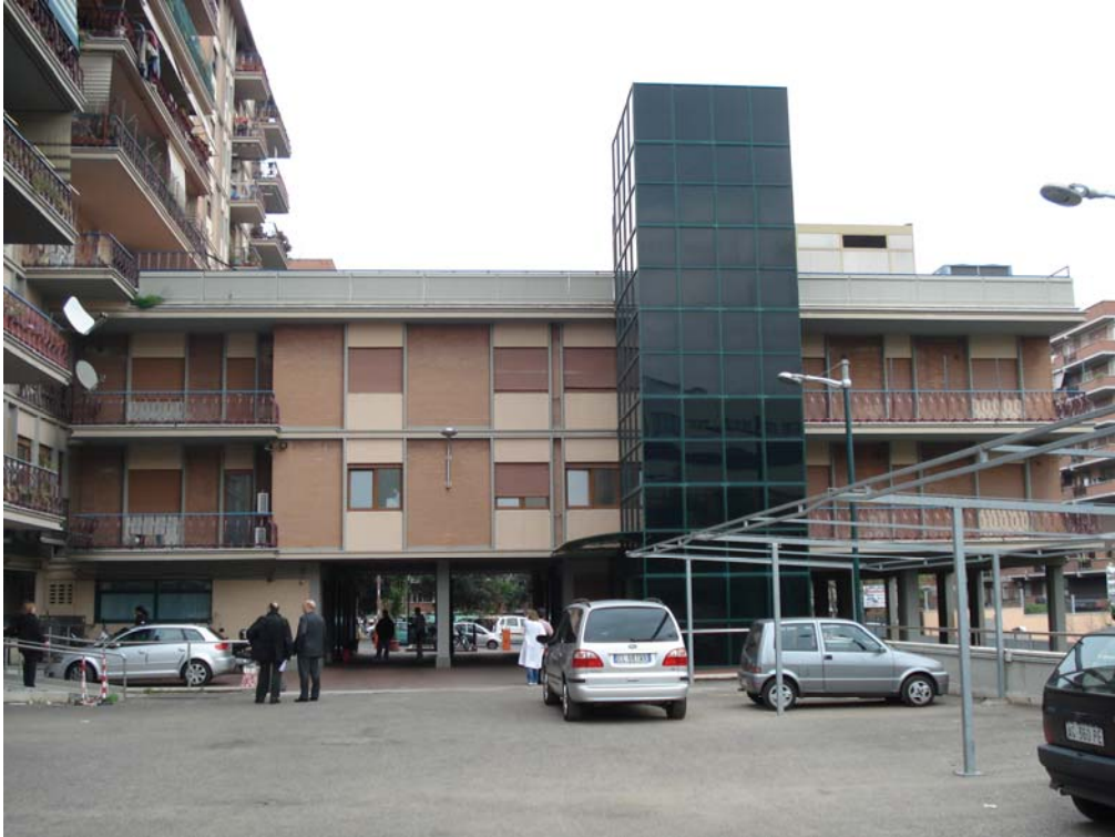
esterno verso corte interna
